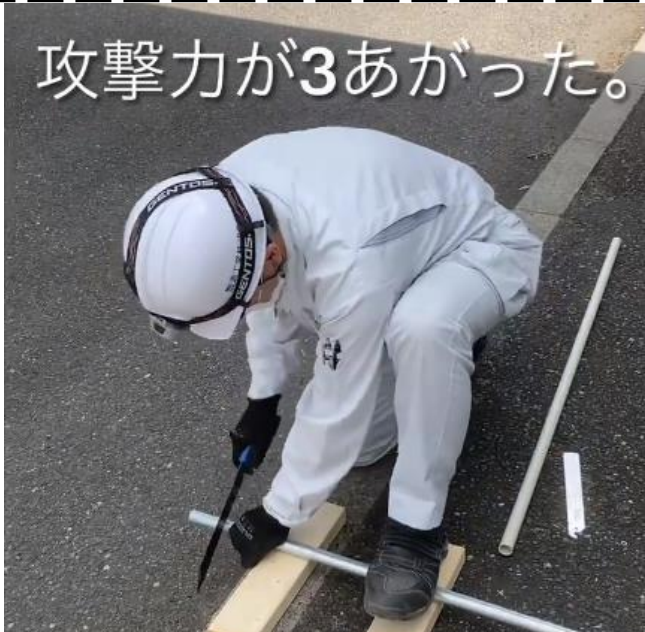
塩ビパイプと鉄パイプをカットしました。鈴木
